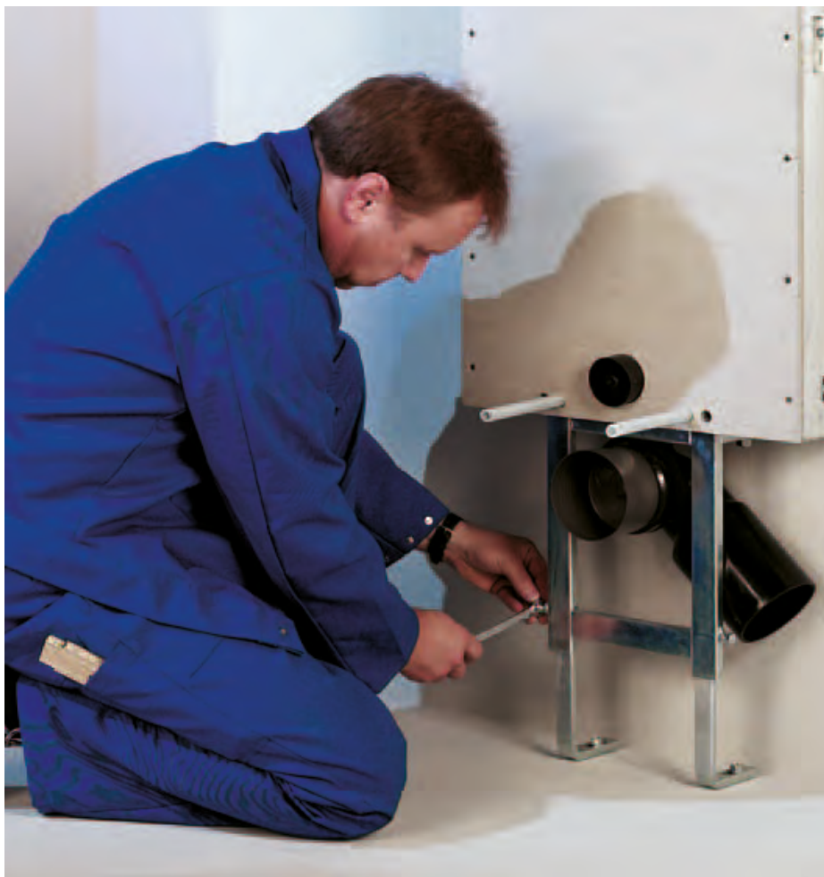
Montage simple: les pieds et les équerres de fixation sont variables.
