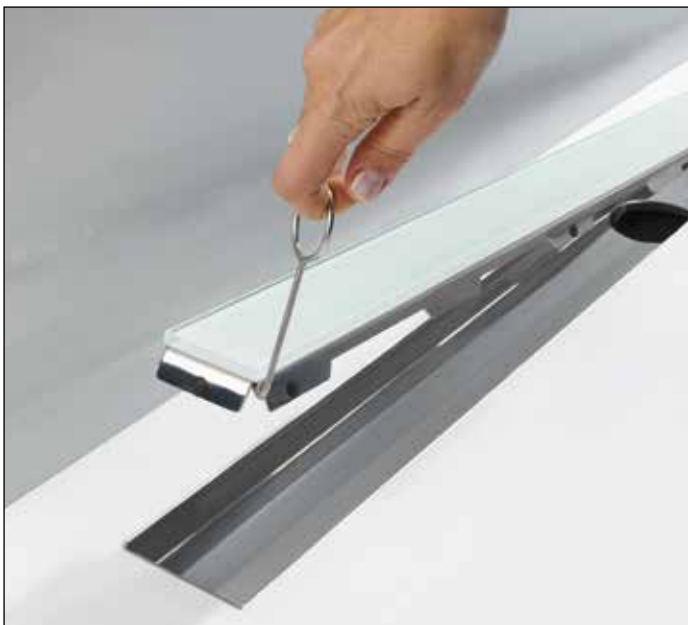
Abdeckung mit dem Aushebewerkzeug herausnehmen
