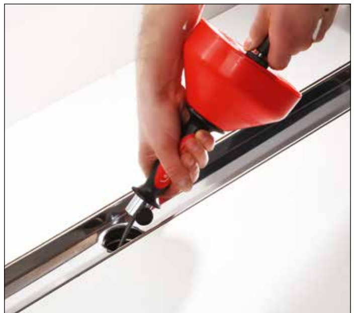
Abflussleitung mit kleiner Handspirale säubern
