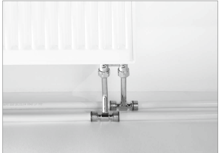
Heizkörperanschluss mit HK-Montage-T-Stück
