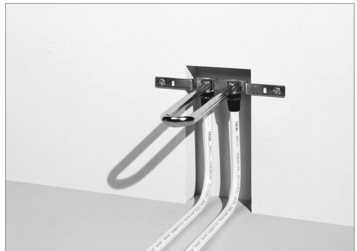
Heizkörperanschluss mit HK-Montagegarnitur, Wandmontage – bereit zum Abdrücken
