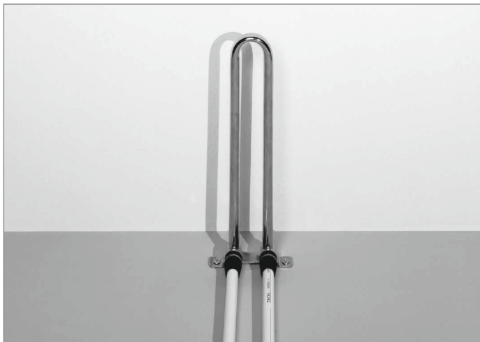
Heizkörperanschluss mit HK-Montagegarnitur, Bodenmontage – bereit zum Abdrücken
