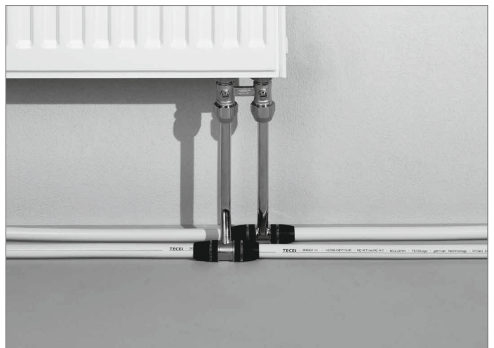
Heizkörperanschluss mit HK-Montage T-Stück
