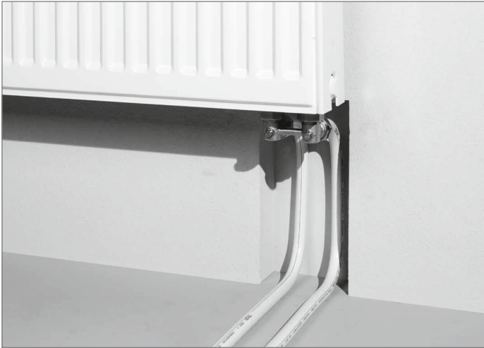
Heizkörperanschluss aus der Wand
