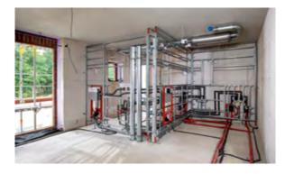
Im Neubau kam TECEsystem als Trennwand zwischen zwei Bädern der Apartments zum Einsatz. Links die Fertigungszeichnung, rechts die Umsetzung in der Praxis. Gut zu erkennen ist, wo die Anschlüsse für die Toiletten, die Dusche und das Waschbecken platziert sind.
