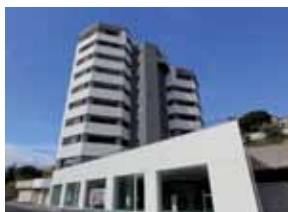
Edificio residenziale multipiano - Cosenza (IT) 4.000 m 2 di pannello bugnato
