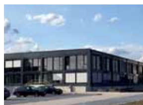
Design Center - Hilter (DE) 2.600 m 2 di pannello a secco 9.700 m di tubo
