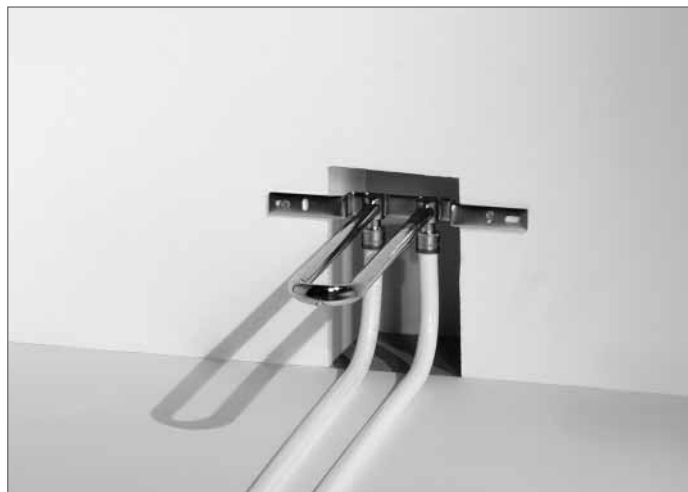
Przyłącze grzejnika wykonane za pomocą garnituru montażowego – gotowe do przeprowadzenia próby ciśnieniowej
