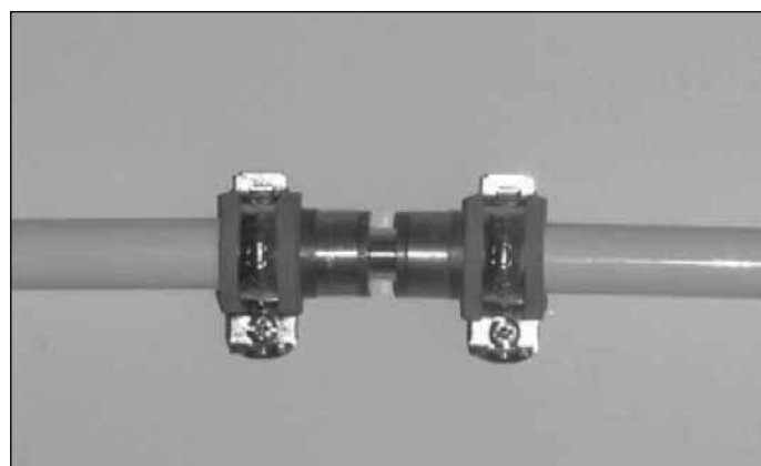
Wykonanie punktu stałego na dwuzłączce prostej
