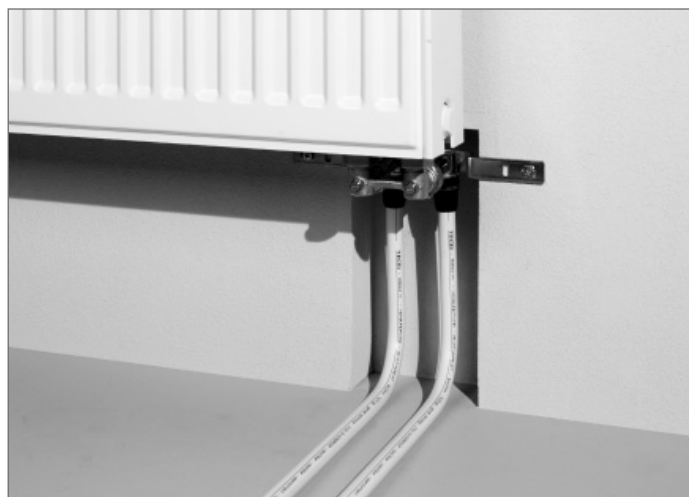
Przyłącze grzejnika wykonane za pomocą garnituru montażowego do grzejników VK montaż ze ściany – po przyłączeniu do zespołu przyłączeniowego grzejnika
